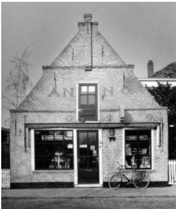
Winkel annex woonhuis, rijksmonument Kerkplein 25 -- Hippolytushoef (1981)
